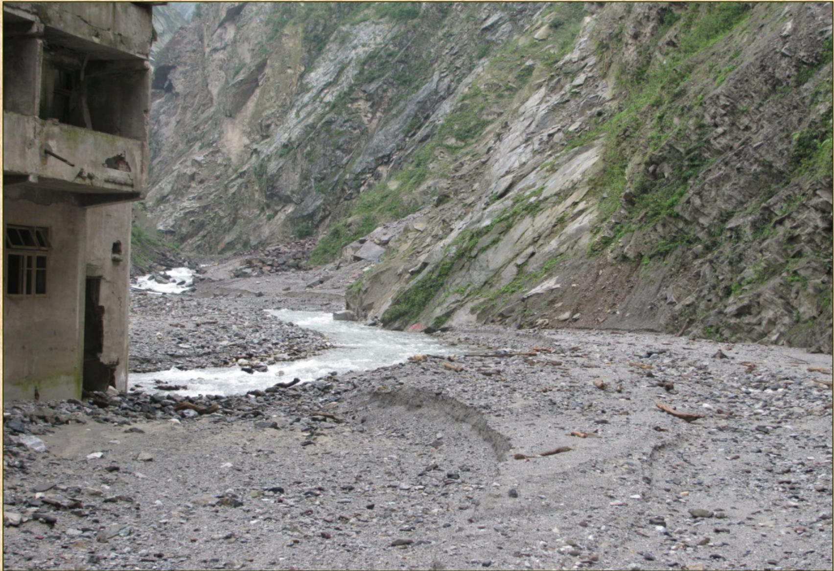
2010 河道改移，抬高河床，冲毁保通路
