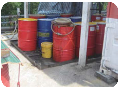
图1-10：化学物品应放在有盖和有底盘的地方、分类存放 ▶
