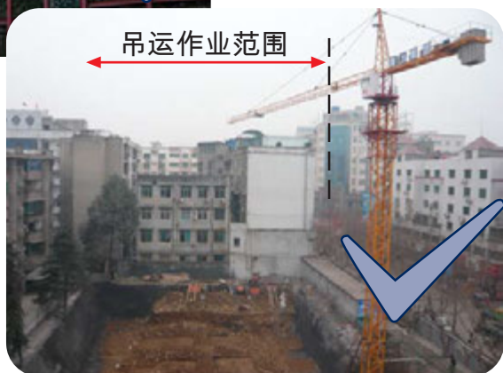
图7-2(右)：▶ 进行高吊运时，吊运物不进入街道上，只留在工地范围内
