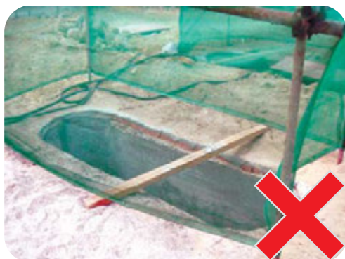
图4-2：物料存放应远离孔桩至少1米外，更不应堆放过高
