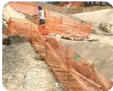
图3-3：基坑或边坡应设有边围栏 稳固行人通道
