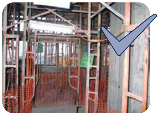
◀ 图2-2：承托架下有一个畅通和有足够 明 的人行通道，建议高 度至少2米
