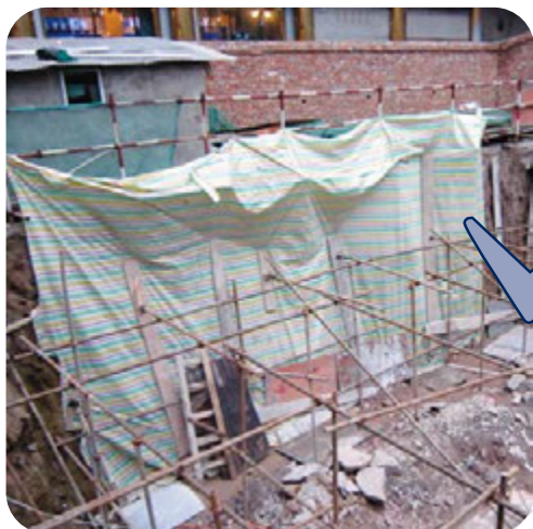
图3-10：坑边有足够支撑，并有塑料布覆盖斜坡面
