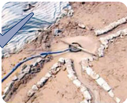
图3-6：坑内设有适当的水设备 ▶
