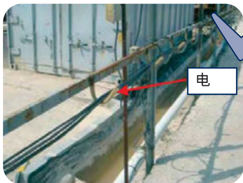
◀ 图1-4：电线应挂起，不应随处放
