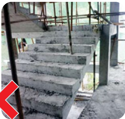
▲ 图5-4(上)，5-5(左)： 楼梯边完全没有防护栏
