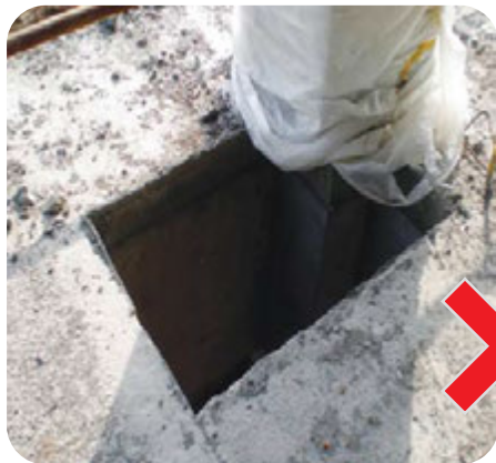
▲ 图5-6(左)，5-7(下)：洞 口和楼面边没有防护和 防坠措施
