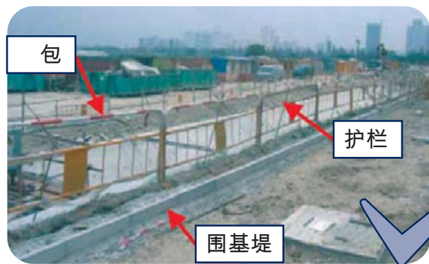
◀ 图3-5： 坑边周围 放置护栏 和沙包
