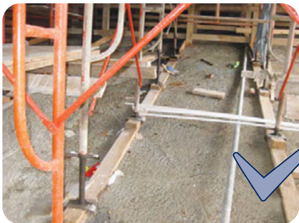
图6-12(右)：模板架应靠在底上
