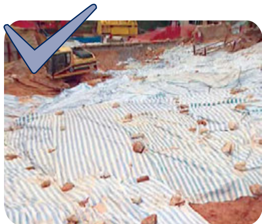
◀ 图3-7：坑内斜坡面应用塑料布覆盖好，减少地表水渗入斜坡以致坍塌
