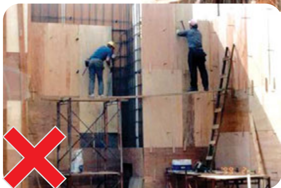
图6-10(上)至6-11(左)：工人没有在稳固的工作台上工作，险象生
