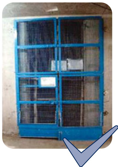
▲ ◀ 图5-1 (上)，5-2(左)， 5-3(下)：电梯井口、楼 梯口、预留井口和洞口 要有防护栏和 板
