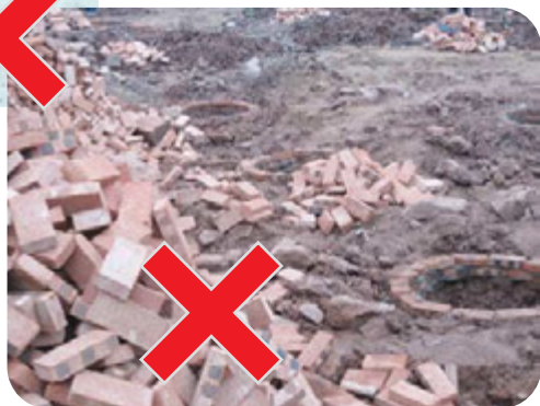
图4-2：物料存放应远离孔桩至少1米外，更不应堆放过高
