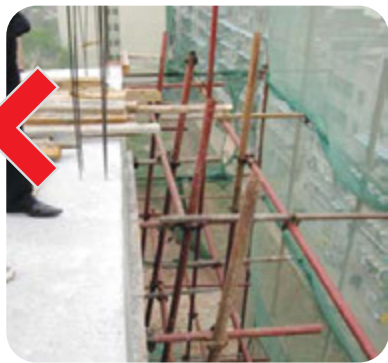
▲ 图5-6(左)，5-7(下)：洞 口和楼面边没有防护和 防坠措施
