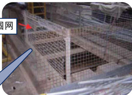
▲ ◀ 图5-1 (上)，5-2(左)， 5-3(下)：电梯井口、楼 梯口、预留井口和洞口 要有防护栏和 板
