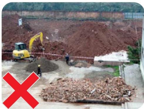
图1-3：工作和材料放置范围，应与公众通道用围板分开 ▶
