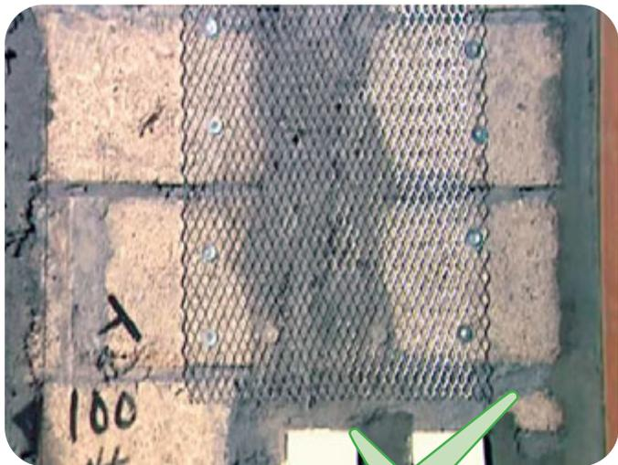
◀ 在砖墙和混凝土墙钉上铁丝网及角网
