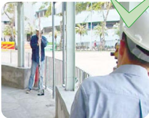
于施工前进行以下监测工作，以确保开挖和支撑工程得以安全进行，并定期对附近建筑物做各类监察
