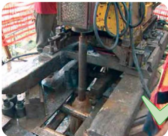
◀ 预先钻探，确定承托岩层的深度
