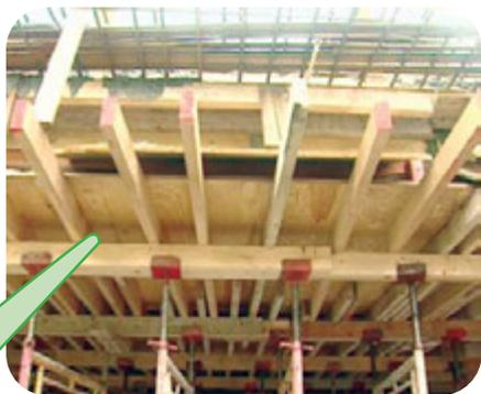
▲ 模板架装有可调节的螺丝头，以调整楼面水平
