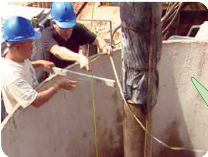
▲ 由工程师测试钻孔的深度及垂直度
