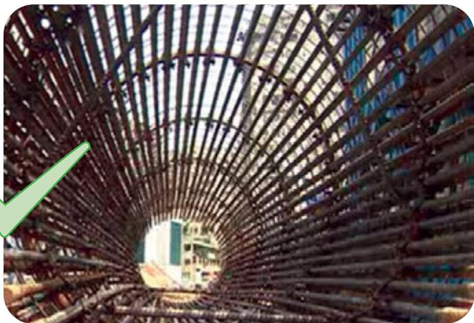
▲ 在钢筋上的适当间距加装环形箍筋来承托
