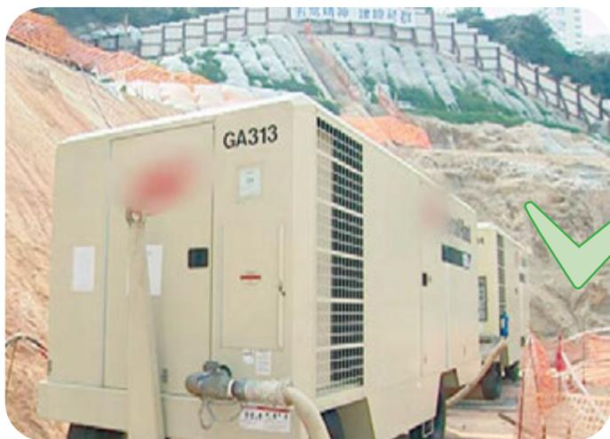
▲ 采用低噪音机械，以减低施工时所产生的噪音
