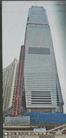
環球貿易廣場的建築工程
