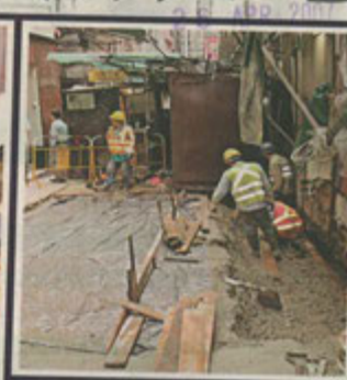
工人昨傍晚合力鋪上水泥填平深坑。
