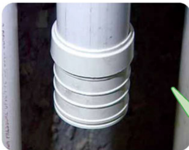
▲ 离地面的排水管要安装适量的伸缩 配件，防止水管移位时造成漏水
