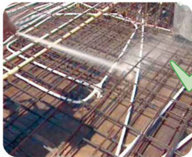
▲ 浇筑混凝土前浇湿模板
