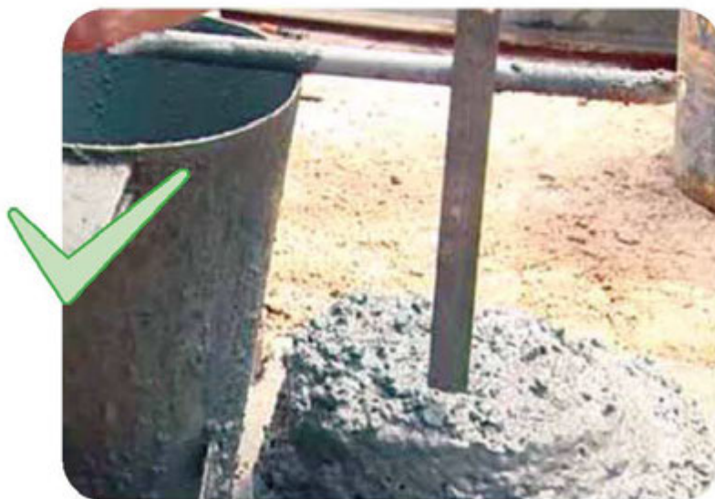
▲ 宜采用“自流式”混凝土
