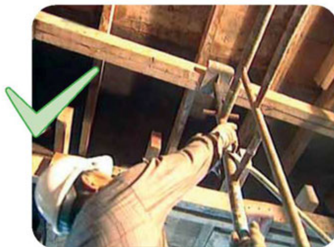
▲ 浇筑混凝土前检查模板，确保模板稳固
