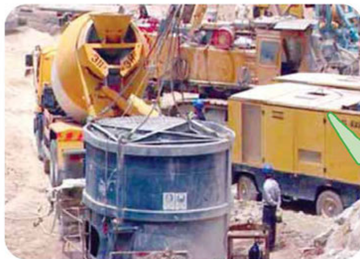
▲ 每根桩柱的混凝土浇筑必须一次完成
