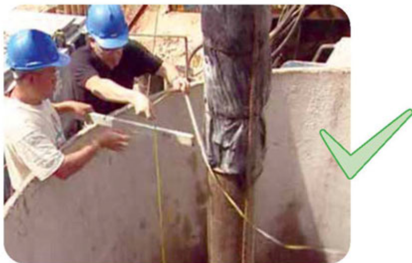
▲ 由工程师测试钻孔的深度及垂直度
