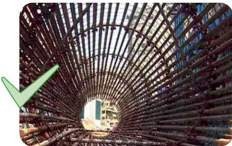
▲ 在钢筋上的适当间距加装环形箍筋来承托
