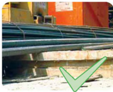
▲ 钢筋存放须有足够承台
