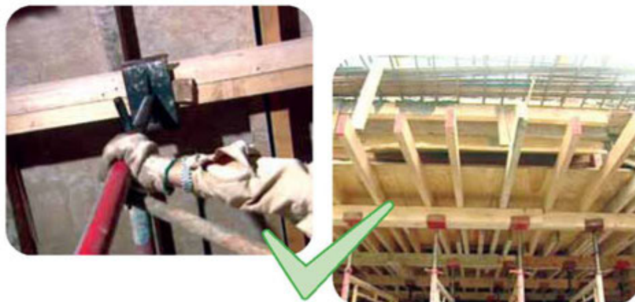
▲ 模板架装有可调节的螺丝头，以调整楼面水平
