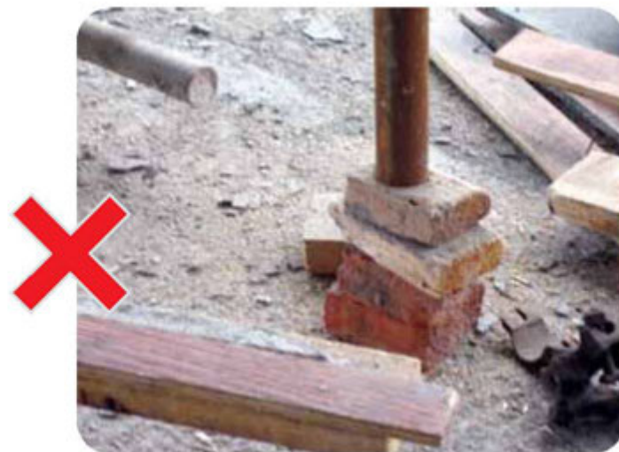
▲ 避免用木楔垫底来调整楼面水平， 模板稳固性将受影响
