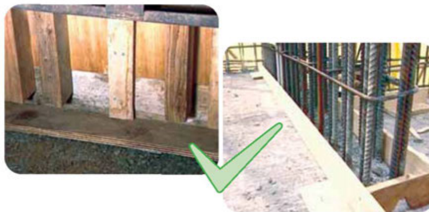
▲ 于模板底部安装脚板，以固定柱墙位置 及防止模板底部移位
