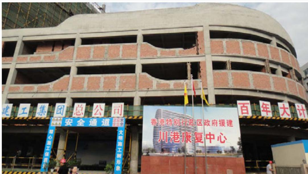
裙楼外墙砖砌体和构造柱施工场景
